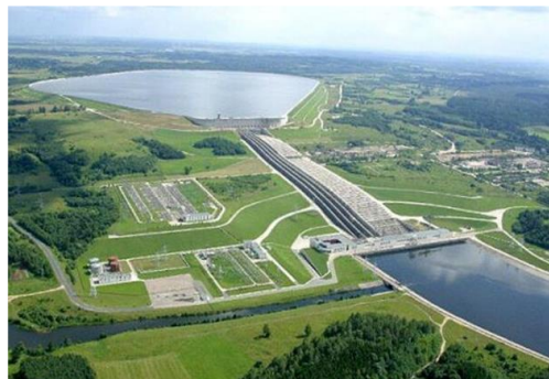
Рис. 1 Гидроаккумулирующая электростанция под г. Каунас, Литва на реке Нямунас. Верхний водоем сделан искусственно.
