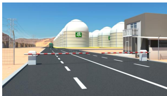
Рис. 6 Станция аккумулярования электроэнергии мощностью 50/300 МВт*ч с использованием цинк-воздушных накопителей
