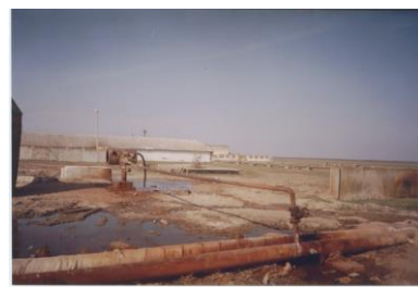
Рис. 2. Скважины в с. Котельниково
