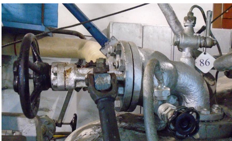
Рисунок 2.1 – Стопорный клапан:
