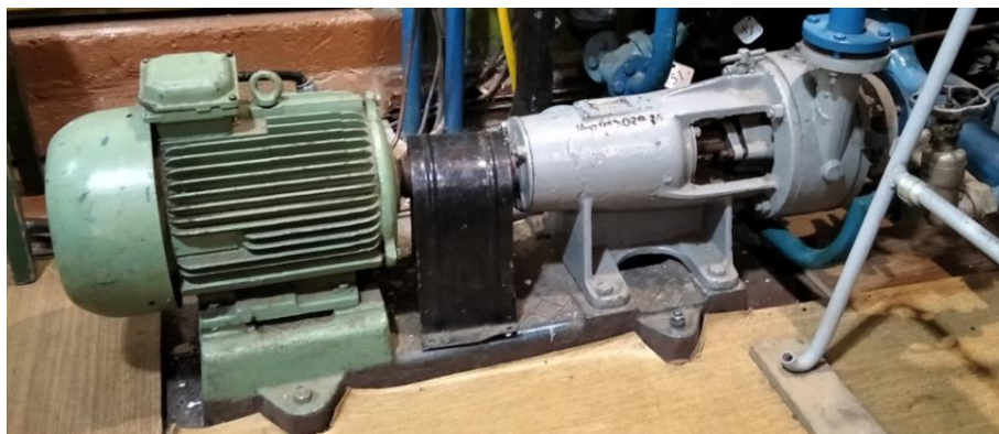
Рисунок 1.6 – Главный питательный насос котла КВС-68
