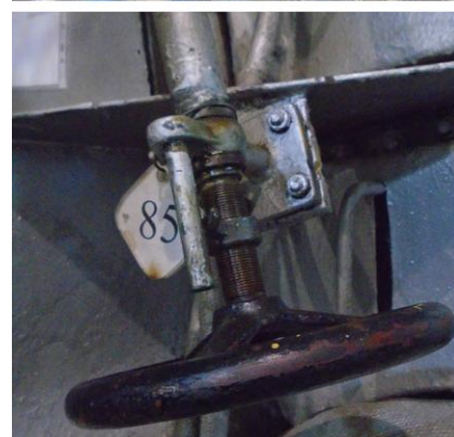
Рисунок 2.4 – Питательный клапан котла КВС-68
