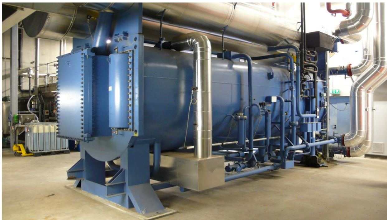
Рис. 1. Абсорбционная холодильная машина (внешний вид)
