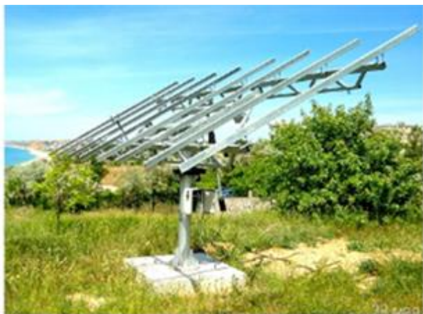
Рис. 2. Система автоматического слежения для фотоэлектрических панелей.
