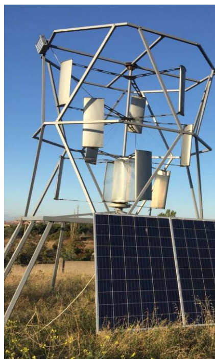
Рис. 1. Основные компоненты электрогенерирующей системы (ветро-солнечная комбинированная установка, г. Севастополь, Сев ГУ, турбаза «Горизонт»).
