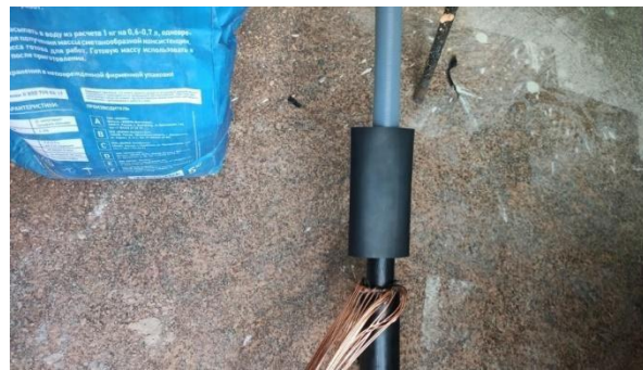
Рис. 7. Монтаж трубок выравнивания напряженности эл. поля.
