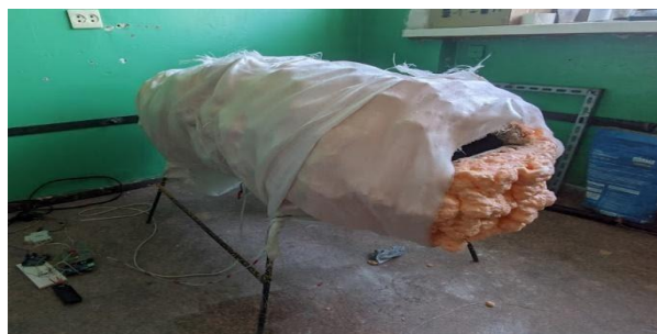
Рис. 4. Покрытие установки слоями стеклоткани.
