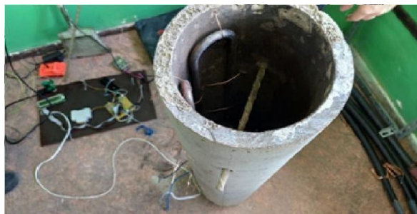
Рис. 1. Монтаж элементов и направляющих.
