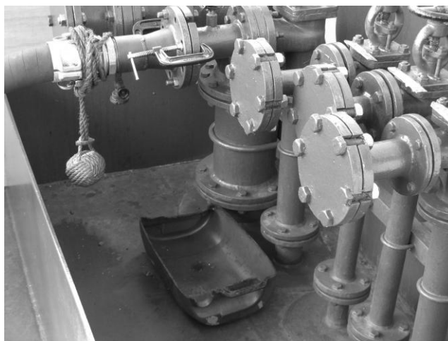
Рисунок 2.4 – Поддон под фланцы премного трубопровода
