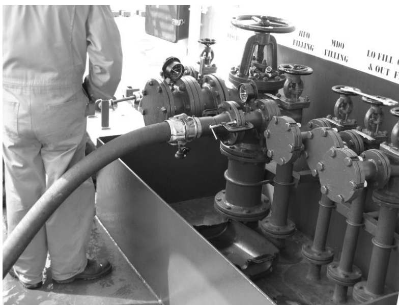
Рисунок 2.1 – Подсоединение передаточного шланга к приемному устройству судна
