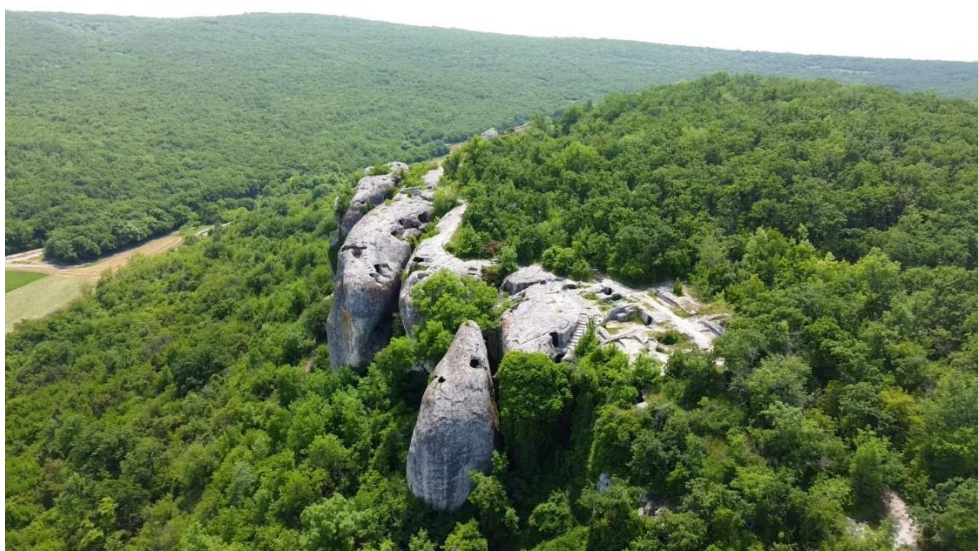
Рис. 7. Оборонительные и жилые сооружения
