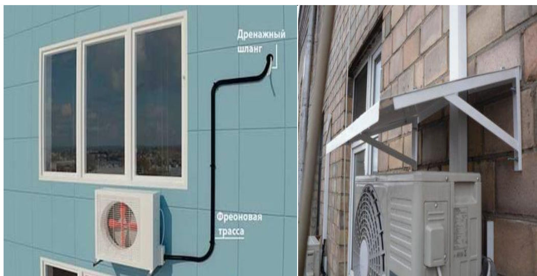
Рис. 3. Размещение наружного блока кондиционера сплит-системы
