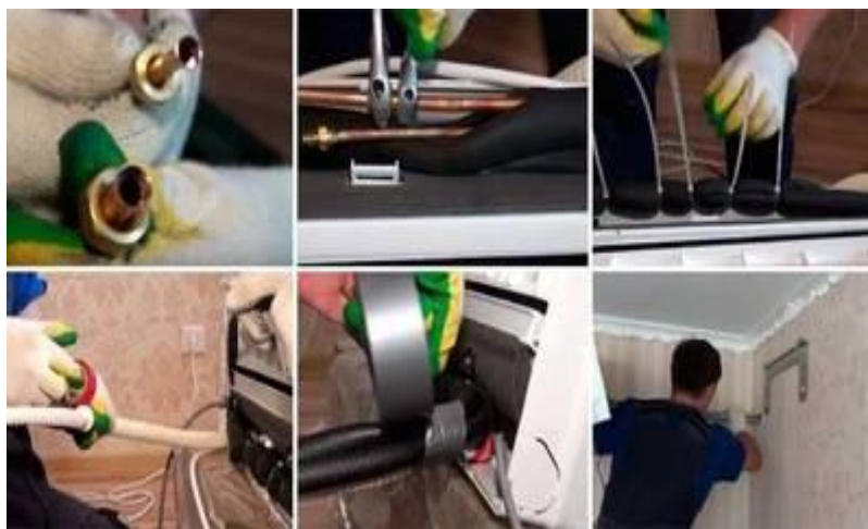
Рис. 6. Прокладка электрических и фреоновых коммуникаций
