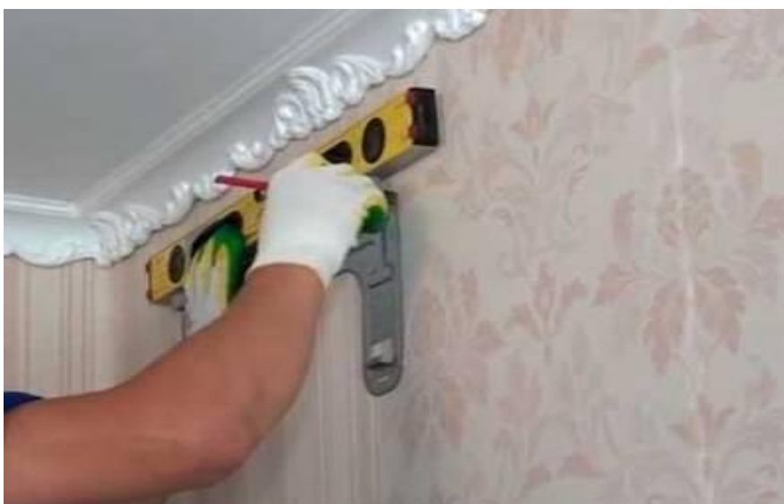
Рис. 5. Монтаж внутреннего блока
