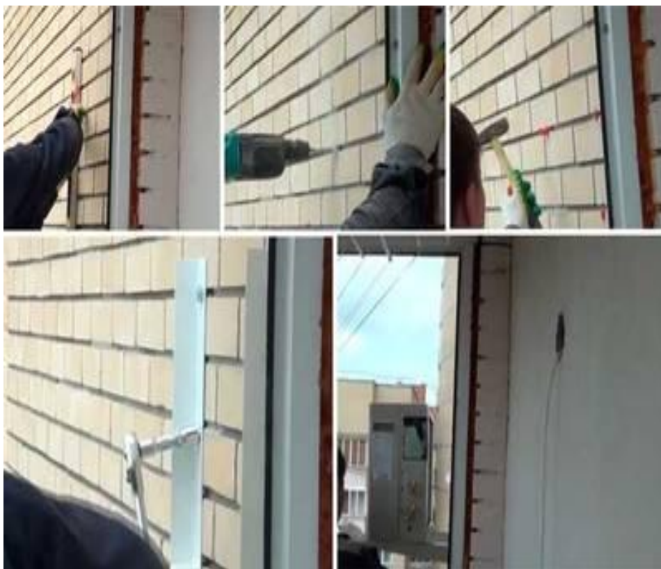
Рис. 4. Монтаж наружного блока
