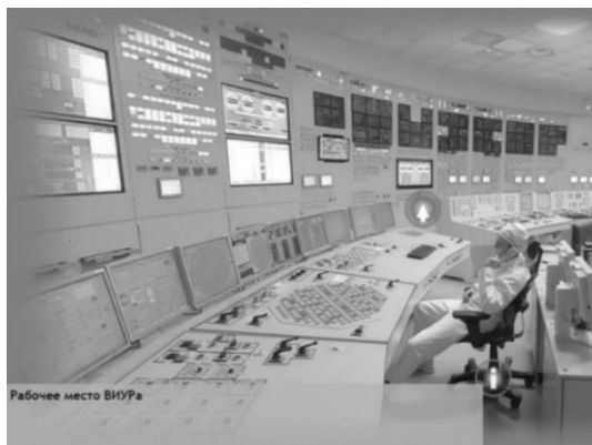
Рис.3. Рабочее место ведущего инженера управления реактором (ВИУР)
