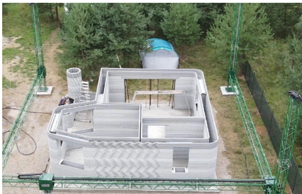
Рис. 5 - Пример промышленного применения строительного 3D-принтера для компактного дома
