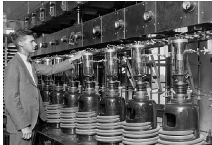
Рис. 5. Общий вид мощного кенотрона (слева) и блок кенотронов UV214 на радиостанции WEAf в Нью-Йорке (1922 г.).
