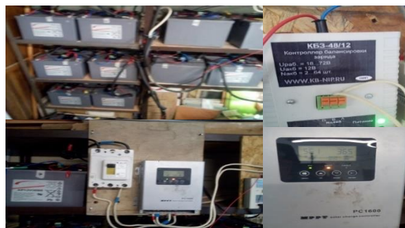
Рис. 2. Солнечная установка мощностью 5,4 кВт с накопителями энергии
