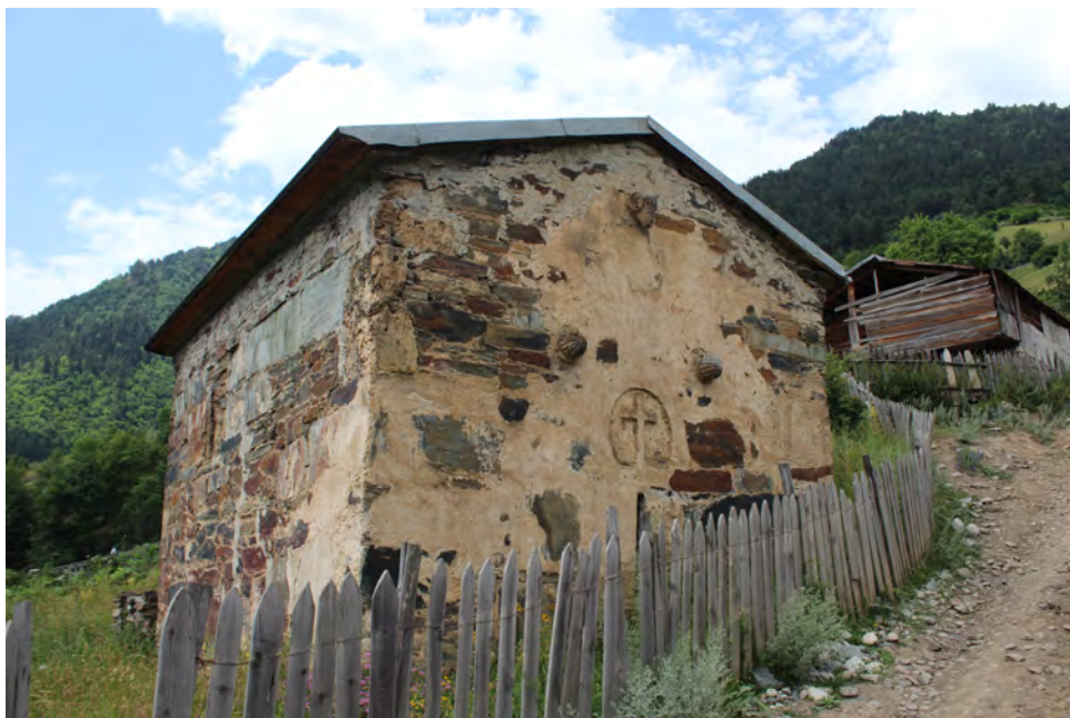
Рис. 2. Церковь в Ёели, восточный фасад (Сванетия, Грузия). Фото автора
