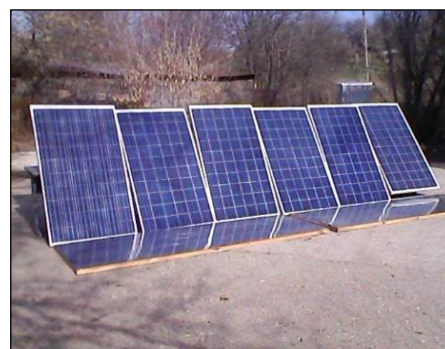
Рис.1. Фотоэлектрическая установка с линейным отражателем номинальной мощностью 1,5 кВт, без учёта работы концентратора.
