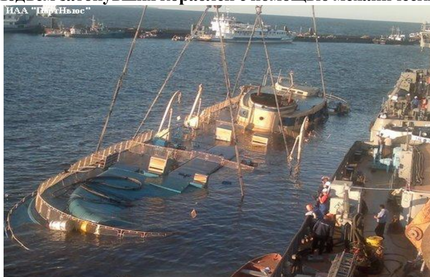
Рисунок 5.2.1.2. Подъем затонувшего судна с помощью механических усилий.
