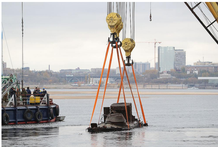
Рисунок 5.2.2.22. Применение судоподъемных строп.
