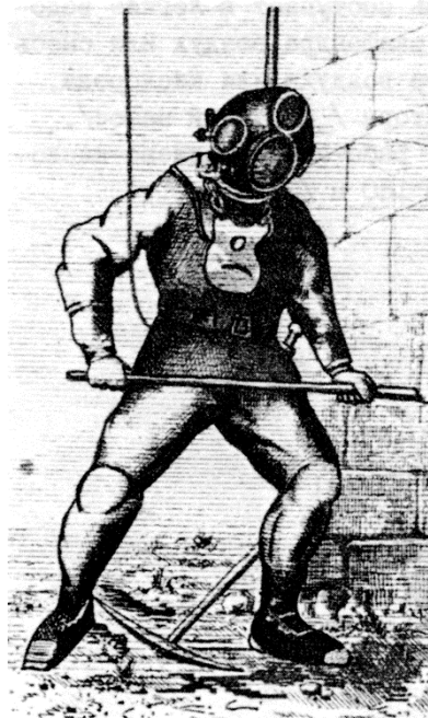
Рис. 1.1.1.24. Вентилируемое водолазное снаряжение Луи Денейруза.
