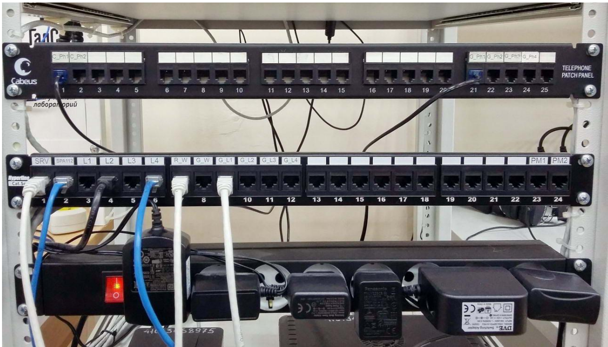
Рис. 3.3 — Расположение элементов панелей коммутации RJ-11 и RJ-45
