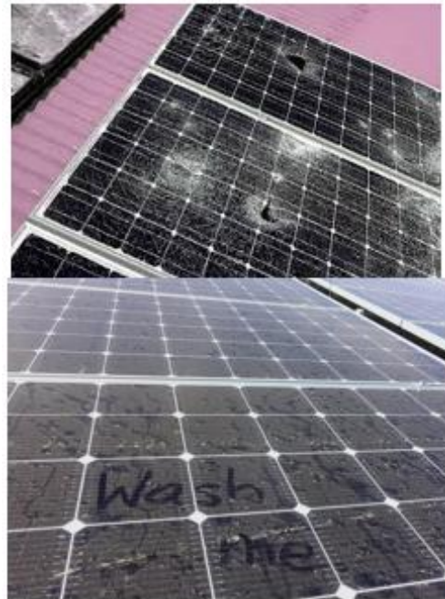
Рис. 1. Повреждение и загрязнение солнечных панелей
