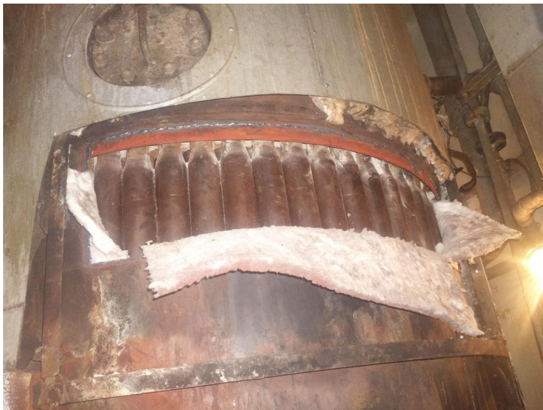
Рисунок Ф.6 – Восстановление участка изоляции котла
