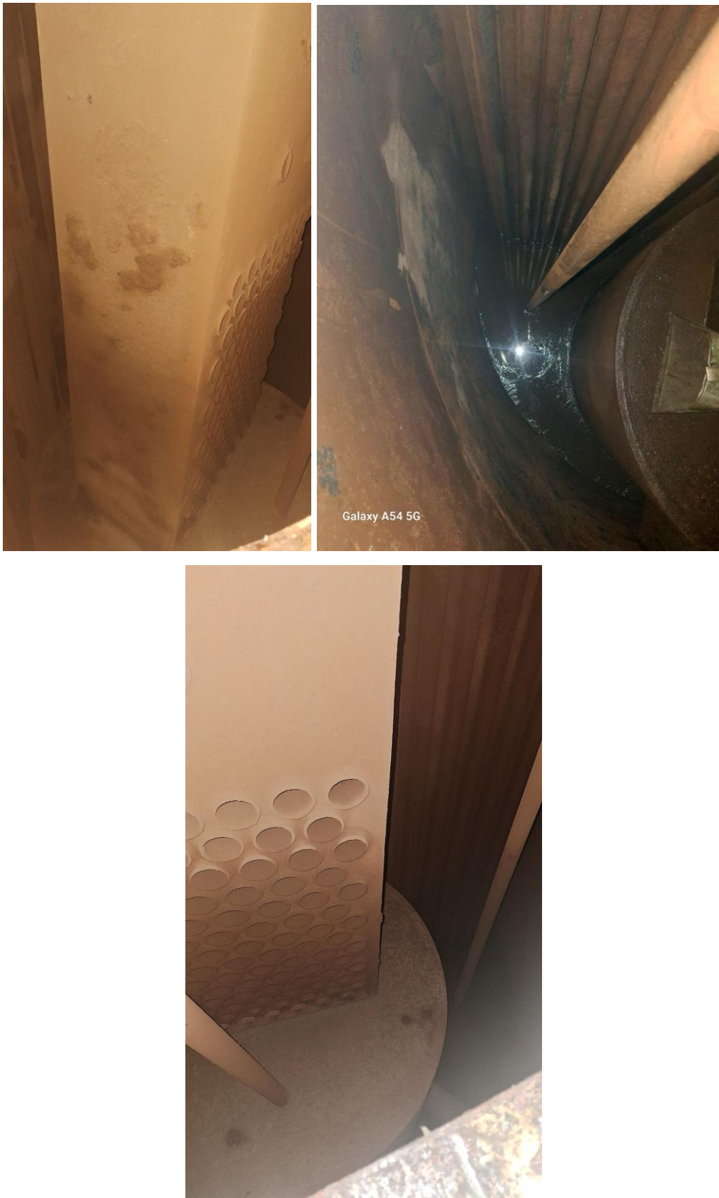
Рисунок Т.7 – Элементы пароводяного пространства котла
