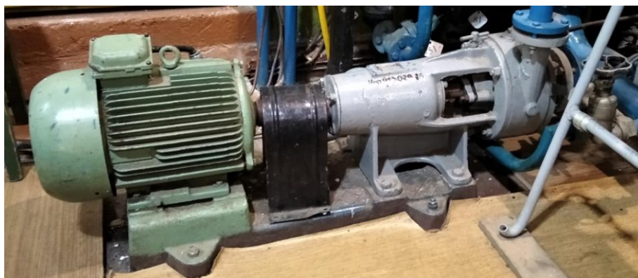
Рисунок 1.6 – Главный питательный насос котла КВС-68
