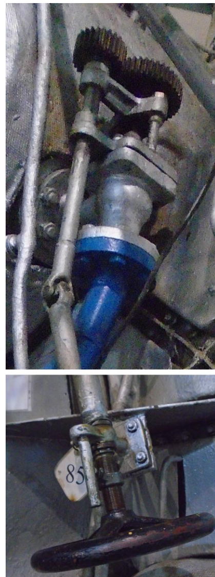
Рисунок 2.4 – Питательный клапан котла КВС-68
