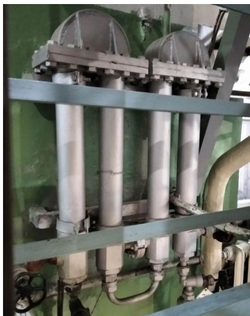
Рисунок 1.14 – Устройство топливоподогревателя
