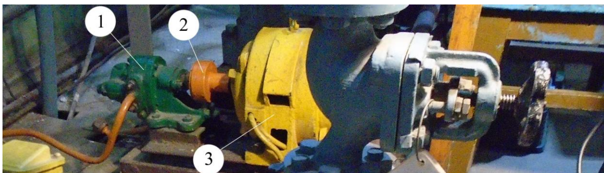
Рисунок 1.9 – Общий вид пускового насоса котла КВС-68: 1 – насос; 2 – муфта; 3 – электродвигатель
