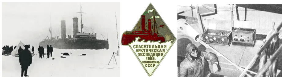
Рис. 21. Ледокол «Красин». Знак участника спасательной экспедиции на ледоколе «Красин» и радист Джузеппе Бьяджи на его борту. Справа от него передатчик ONDINA типа S и приемник Burndept MK IV . 12.07.1928 г.
