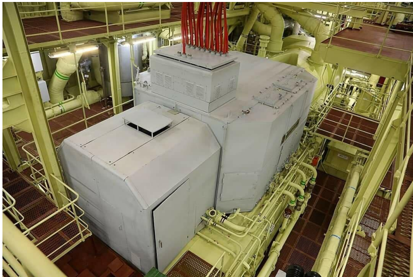
Фото 2.4. Паротурбинная установка мощностью 35 МВт. ПТУ ТК-35/38-3,4 представляет собой блочную машину, которая находится на одной раме вместе с генератором такой же мощности [12]
