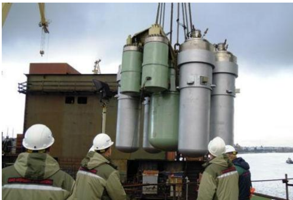
Фото 2.1. Установка реактора КЛТ-40 в корпус судна [12]
