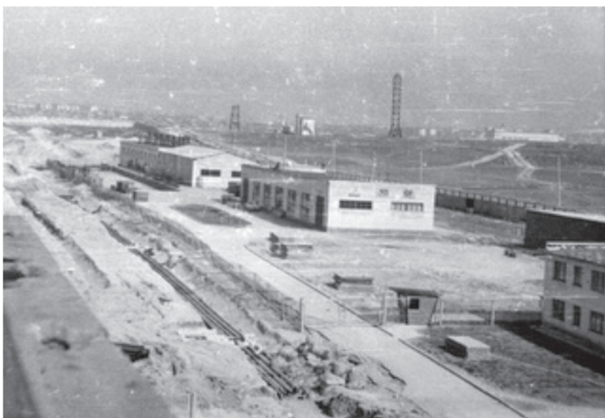
Панорама строительной площадки завода в 1967г.:
