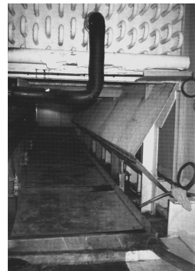
Рисунок 3.2 — Система охлаждения грузовых помещений
