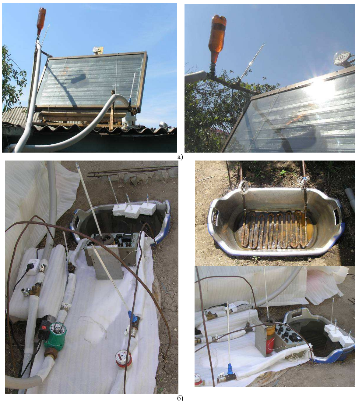
Рисунок 3 – Фотографии компонентов стенда: а) плоский солнечный коллектор, размещенный на кровле здания; б) модель сезонного аккумулятора, заполненного солевым раствором
