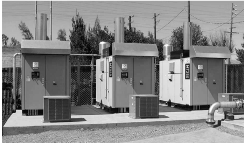
Рисунок 2 – Комплекс газовых турбин миниэлектростанции мощностью до 30 МВт
