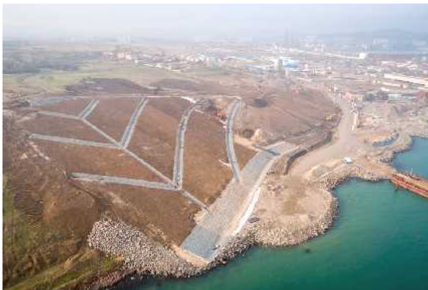
Рис. 4.9. Оползнеопасный участок в зоне выхода мостового перехода на побережье в районе Керчи
