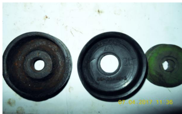
Рисунок В.11 – Осмотр деталей правой стороны поршня
