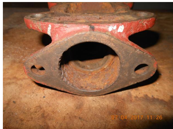
Рисунок В.5 – Осмотр поверхности клапанной коробки, сопрягаемой с корпусом насоса
