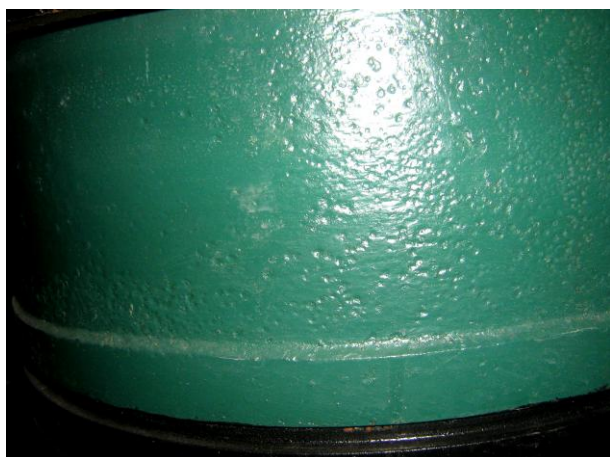
Поверхность ниже окон Рисунок А.38 – Осмотр поверхностей охлаждения втулки цилиндра дизеля типа 8ZD72/48
