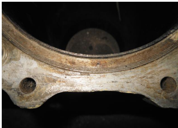
Рисунок А.22 – Осмотр уплотнительной поверхности втулки, сопрягаемой с крышкой цилиндра дизеля типа М-50
