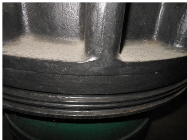
Поверхности ниже окон Рисунок А.39 – Осмотр уплотнительных поверхностей в районе окон втулки цилиндра дизеля типа 8ZD72/48
