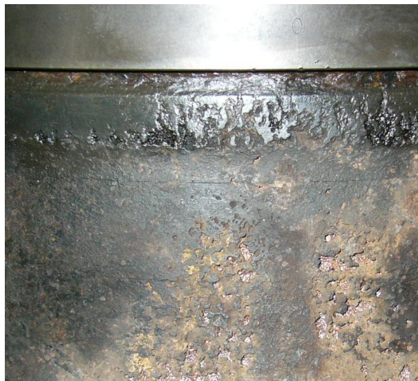
Рисунок А.13 – Пример разрушений верхней посадочной поверхности втулки цилиндра
