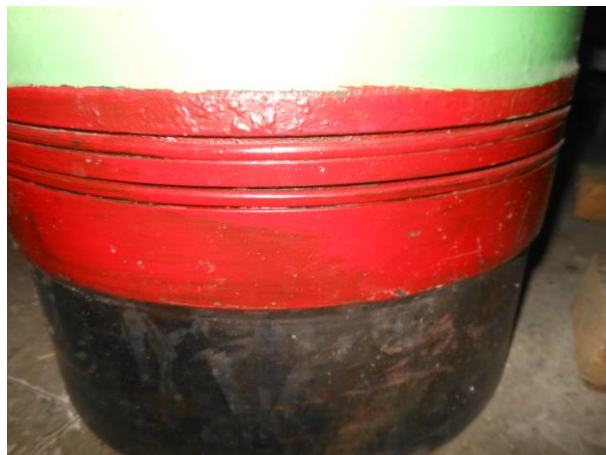
Рисунок А.30 – Осмотр поверхностей нижнего уплотнительного пояса втулки цилиндра дизеля типа 8NVD48.2AU
