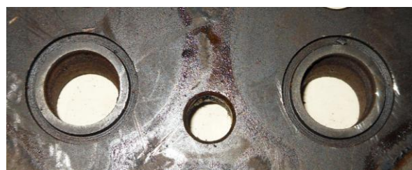
Рисунок Б.27 – Осмотр седел всасывающих клапанов
