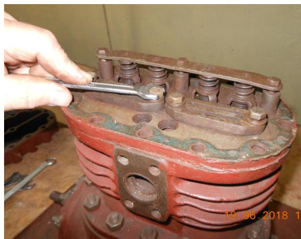
Рисунок Б.10 – Откручивание болтов крепления седел всасывающих клапанов к клапанной доске
