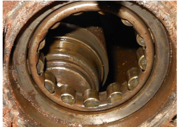
Рисунок Б.74 – Осмотр опорного роликового подшипника коленчатого вала
