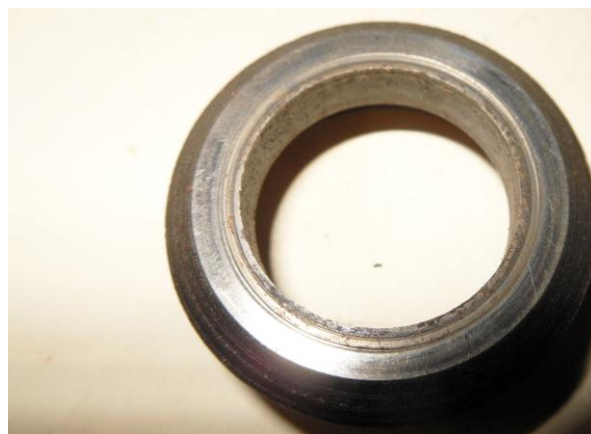
Рисунок Б.58 – Осмотр торцовой рабочей поверхности обоймы
