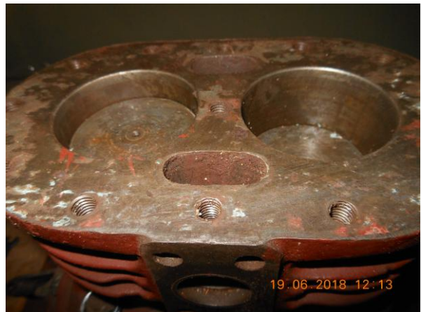
Рисунок Б.31 – Осмотр уплотнительной поверхности блока цилиндров со стороны клапанной доски
