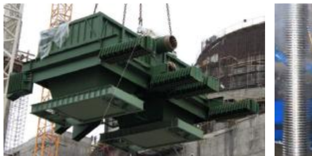
Рис. 5. Воздушный ТК СПОТ ПГ: трубный пучок с коллекторами (а), ТК в сборе с шиберами перед монтажом в воздушную шахту (б), оребренная труба (в)
