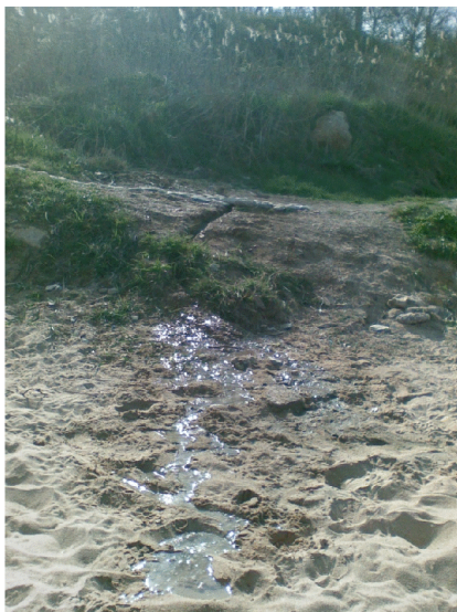
Фото 3. Один из постоянных водных источников у основания оползня, апрель 2016 г.
