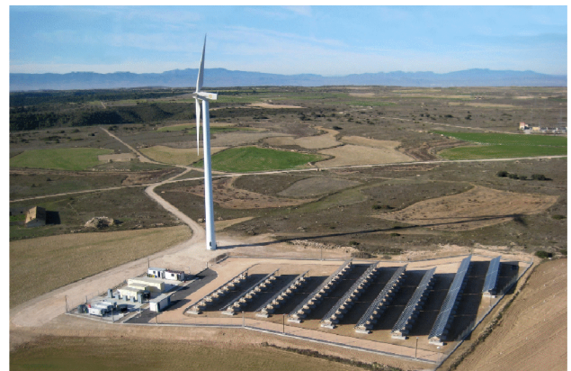
Рис. 12. Гибридная электростанция с ветрогенератором, солнечными фотоэлектрическими панелями и резервными дизельгенераторами.
